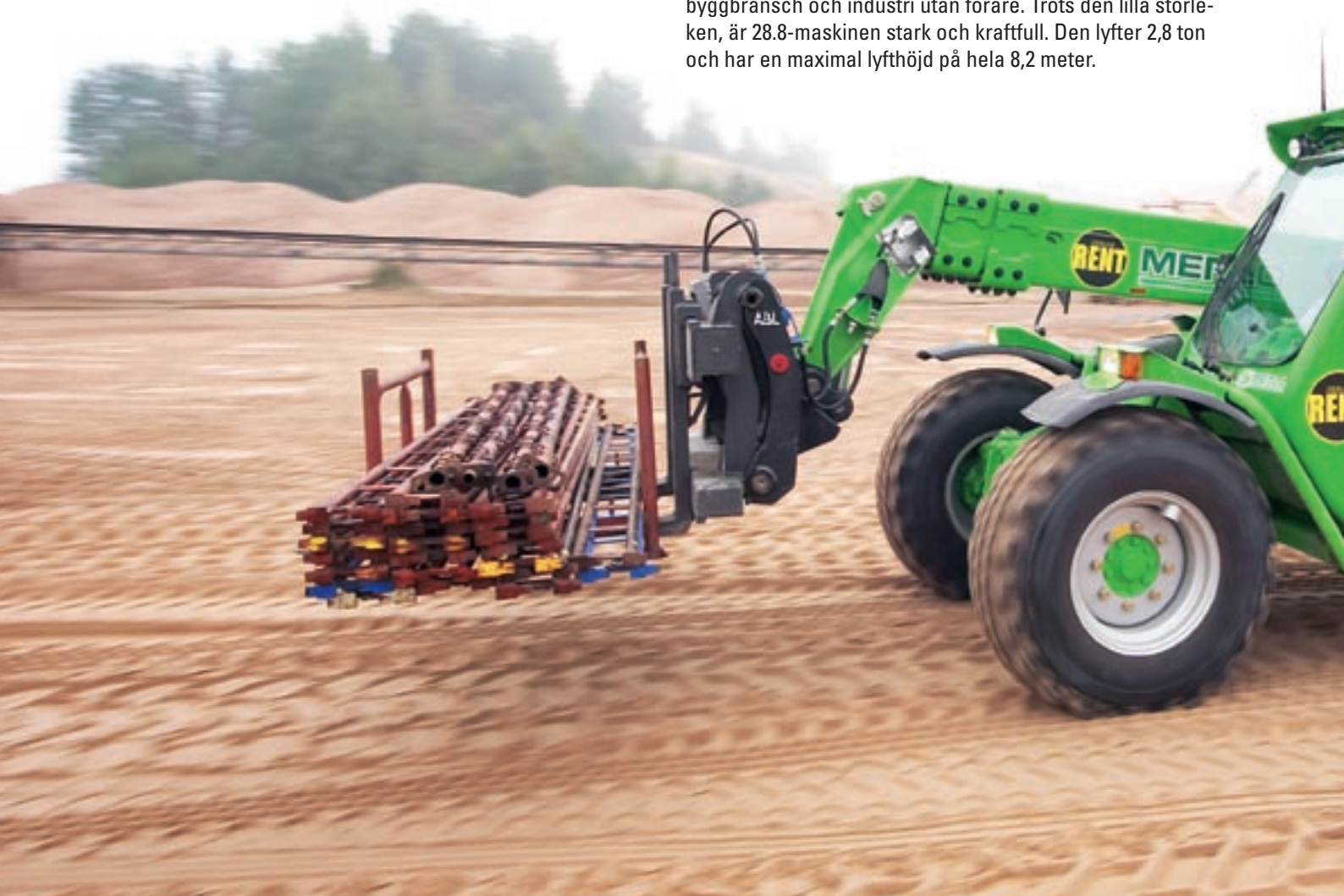
Christer Carlsson hämtar material till ställningsbygget.
